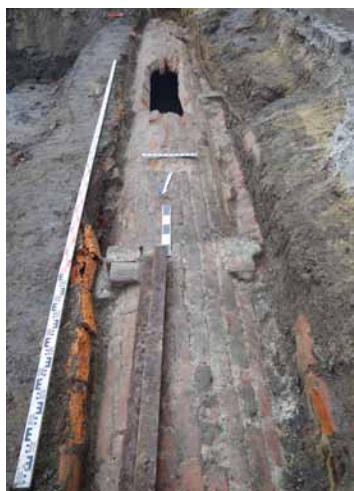
Ceglano-kamienny kanał burzowy odkryty w wykopie nr 2, datowany na koniec XIX i początek XX wieku (fot. P. Kocańda, FROA 2017)
