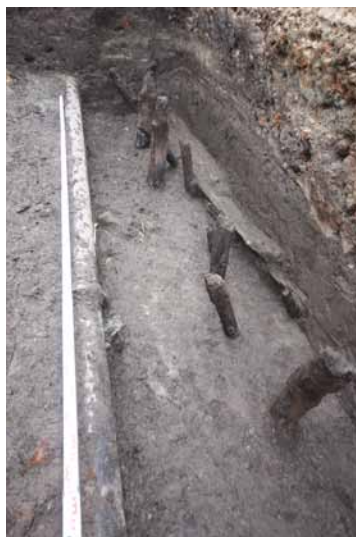
Drewniane elementy wzmacniające drogę, wbite pionowo i ukośnie (fot. K. Drewniak, FROA 2021)
