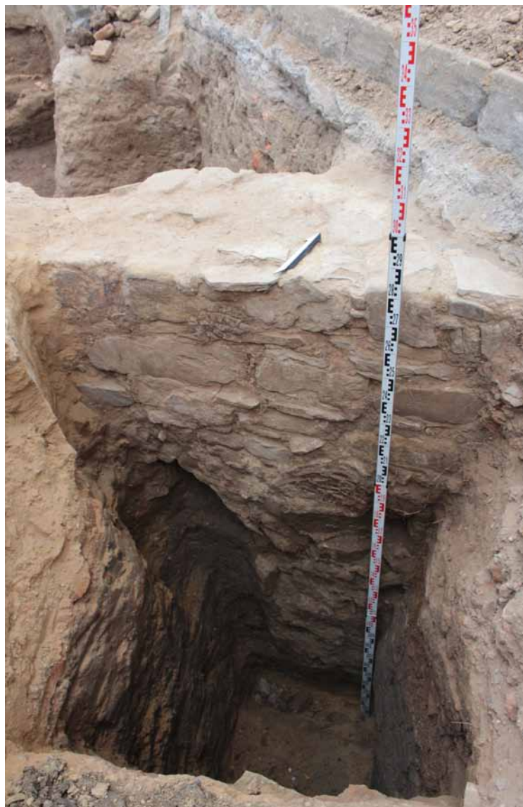
Fundament muru ogrodzenia cmentarza (fot. T. Tokarczyk, FROA 2017)
