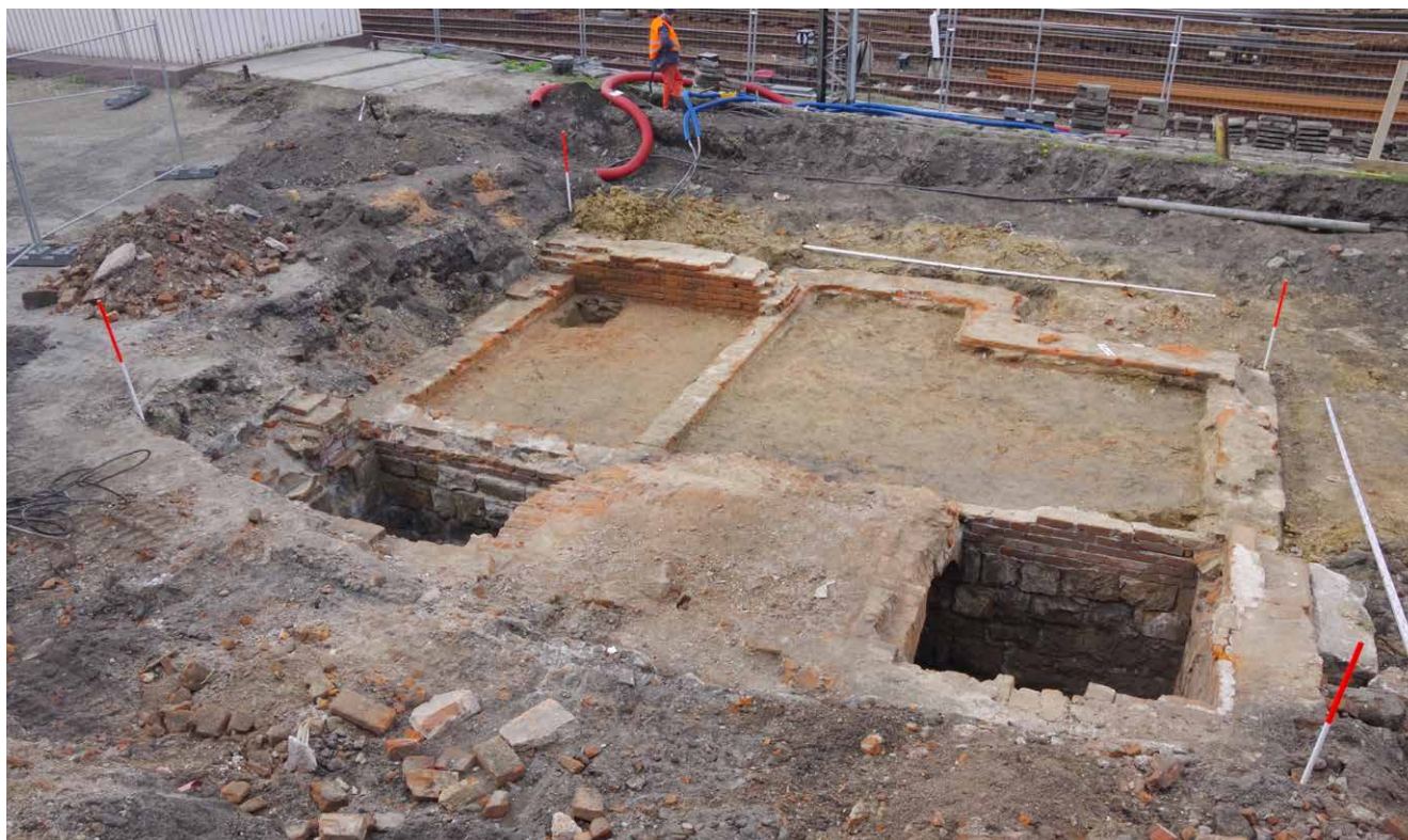
Fundamenty budynku kolejowego odkryte przy ul. Stanisława Jabłońskiego (fot. P. Kocańda)
